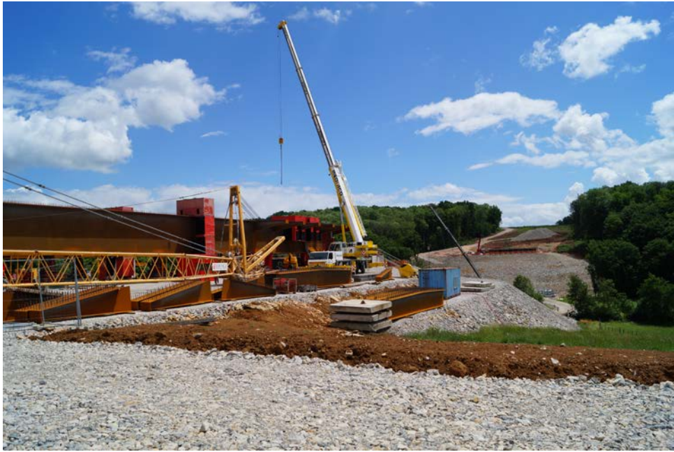
Charpente en cours d'assemblage
