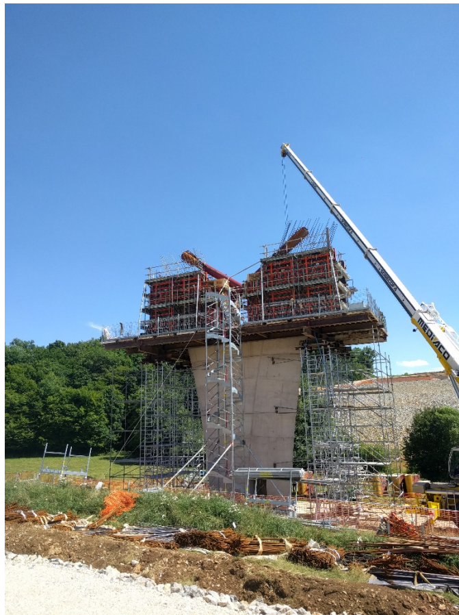
Pose de la croix de Saint-André entre le « Y » de la pile P1
